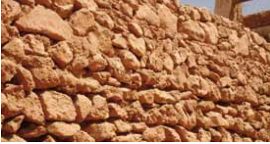
حجارة موضوعة بعناية فوق بعضها دون استعمال الرابط
