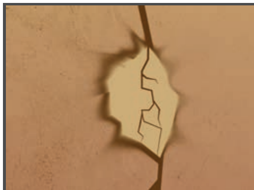
L'élargissement continu des fissures et la rupture de la couche de plâtre
