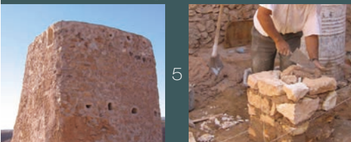
5 - استعمال الملط في أشغال البناء
